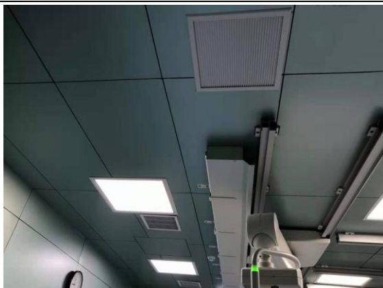
Pic7 机房顶棚通风口
