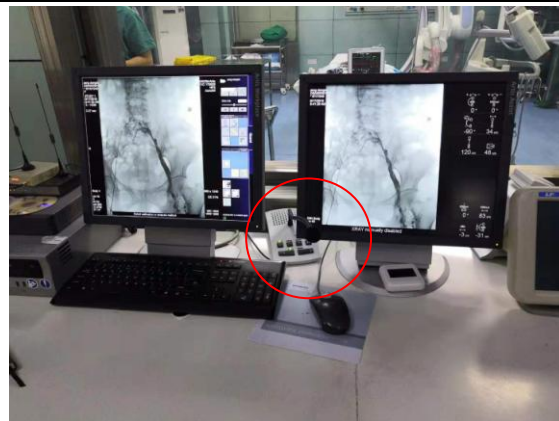
Pic3 控制室内对讲装置
