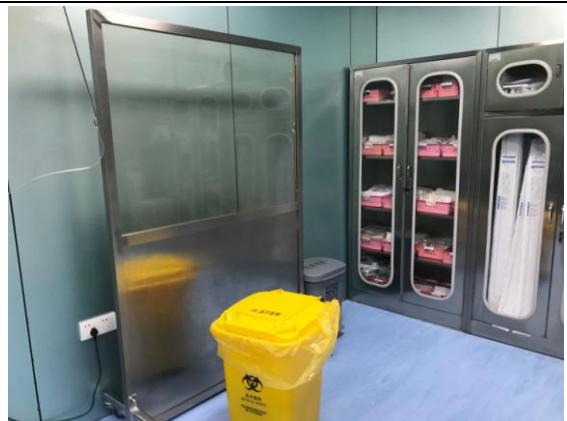
Pic12 机房内移动铅屏风
