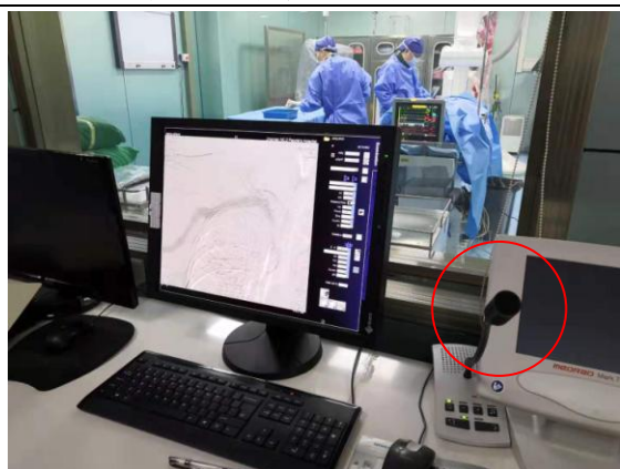
Pic3 控制室内对讲装置
