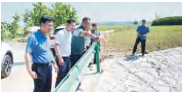
党委班子成员下沉到包联村——沙洋县吕集村现场帮扶村泵站建设情况
