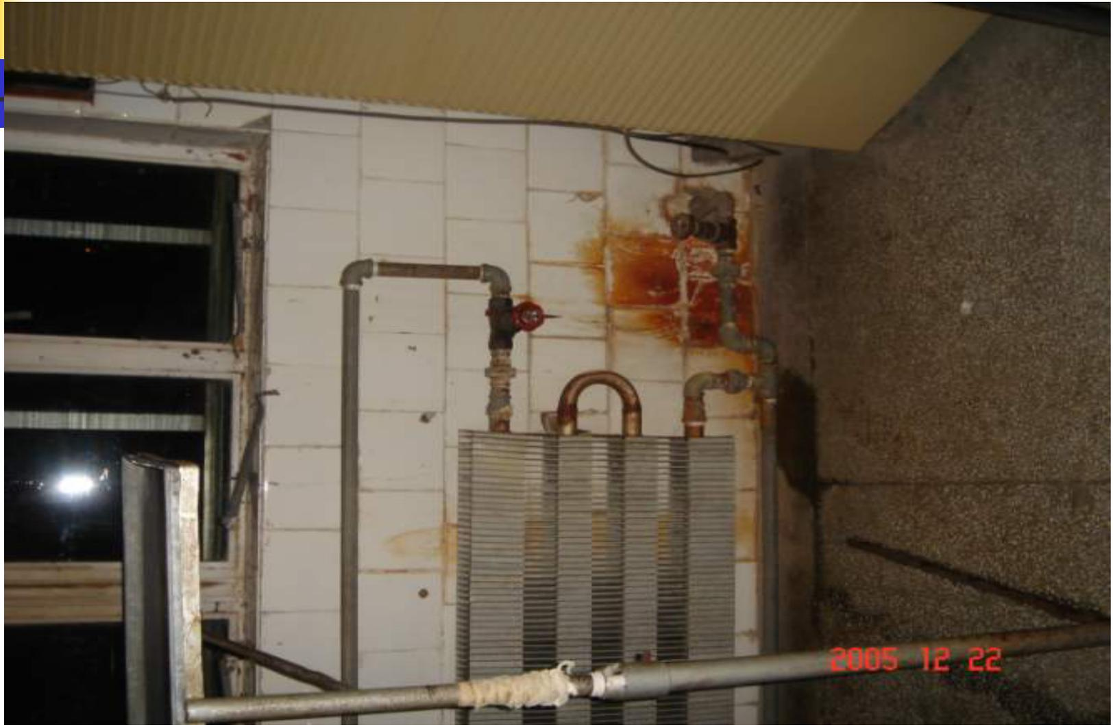
手术室墙壁一角漏雨、纱窗破损
